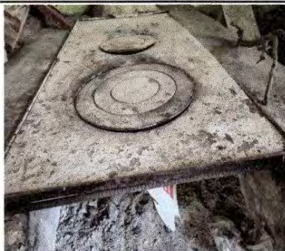
Foto 15: Sustitución de plancha de metal de 3 hornillas
