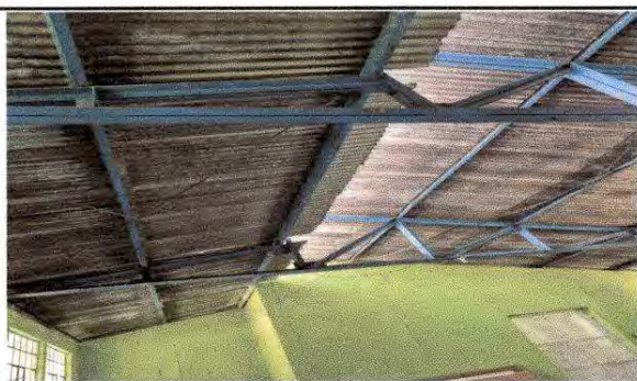
Foto 11: Sustrución de ducto eléctrico+ accesorios
