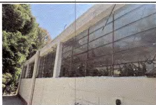
Foto 12: Fabricación e instalación de balcones de hierro en ventanas
