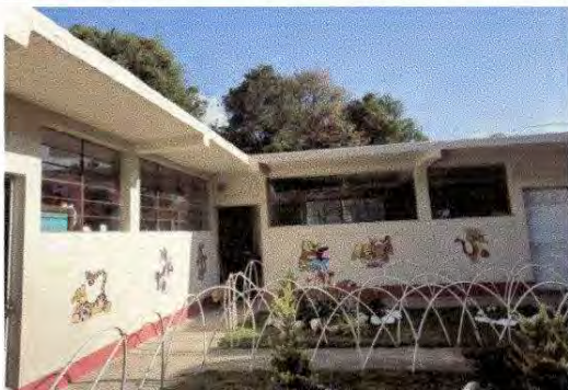
Foto13: Fabricación e instalación de balcones de hierro en ventanas
