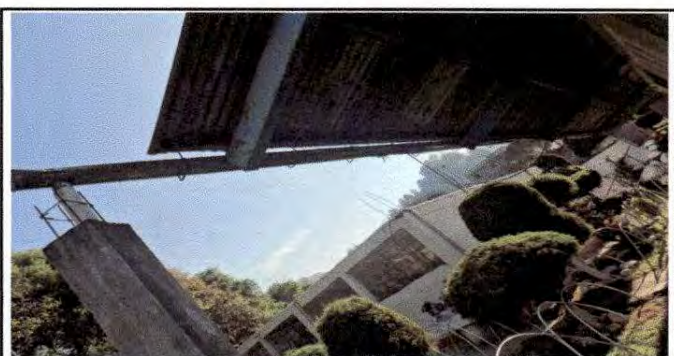
Foto 5: Sustrución de canal PVC
