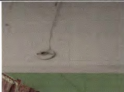
Foto 8: Sustrucion de plafoneras
