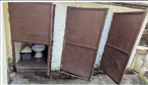
Foto 2: Sustrución de puerta en servicios sanitarios
