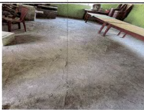
Foto 4: Sustrucion de piso de cemento liquido por piso cerámico
