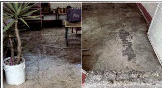
Foto 3: Sustrucion de piso de cemento liquido por piso cerámico
