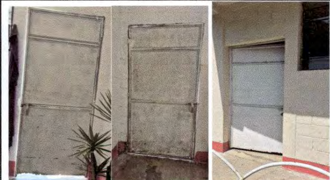
Foto1: Sustrución de Puerta
